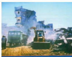
Іл. 34.7. Рятувальні роботи після землетрусу
