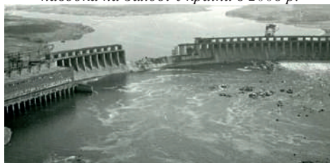
Іл. 33.7. Зруйнована вибухом гребля Дніпрогесу в 1941 р.
