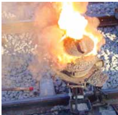
Мал. 53 Алюмотермія — відновлення металів з їх оксидів за допомогою алюмінію
